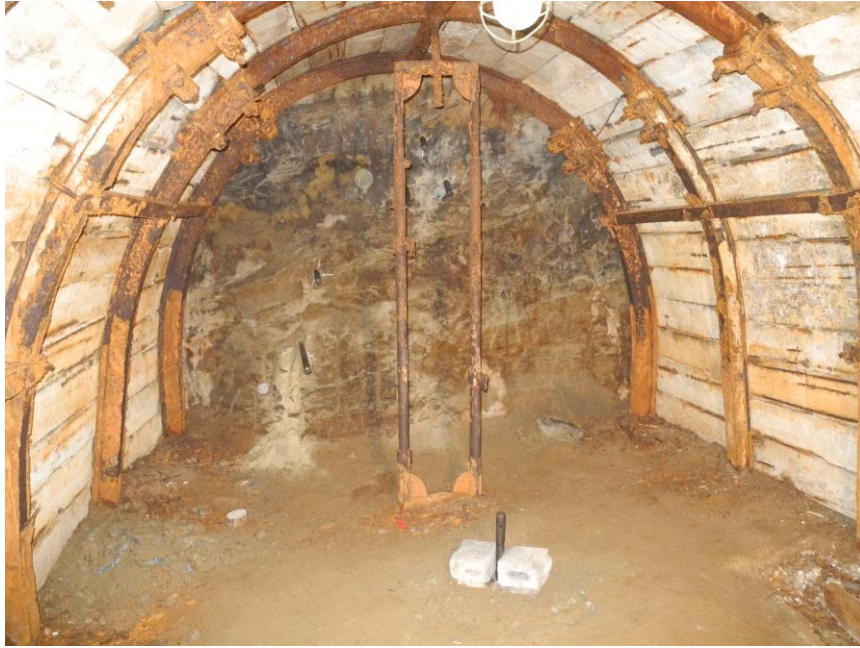
Рисунок 4.2 – Второй северный откаточный ходок второй северной лавы
