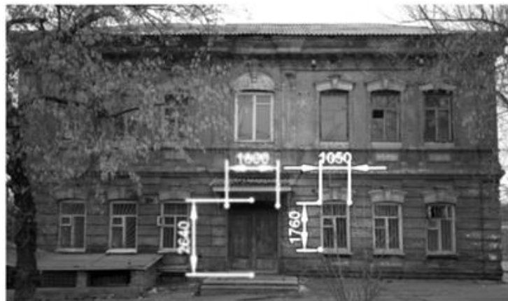
Рисунок 3.19 – Физические размеры окна и входной двери здания
