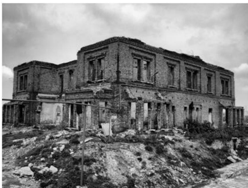
Рисунок 4.2 – Нынешнее состояние дома Юза, главный фасад [96]
