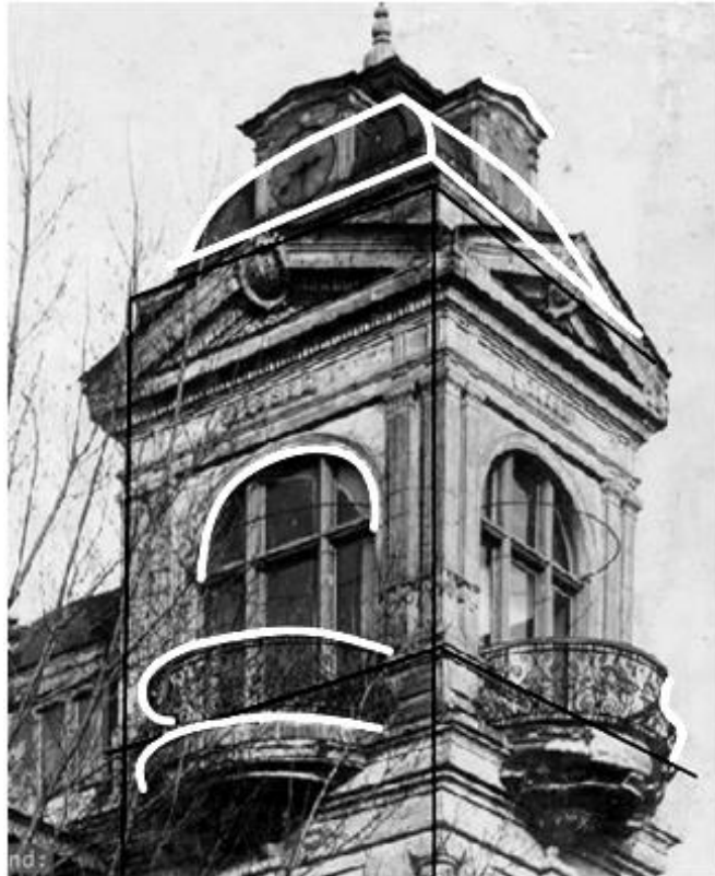
Рисунок 4.14 – Указание кривых линий для отыскания относительных натуральных величин
