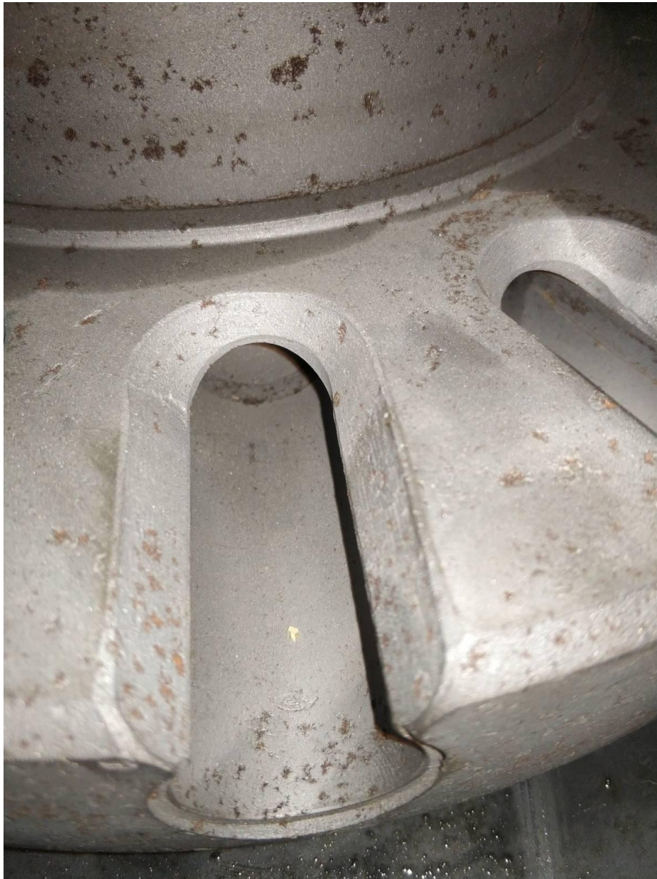
Рисунок П2. 1 – Коррозия ротора гидродвигателя
