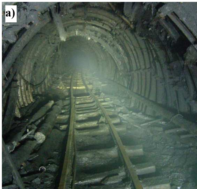
Рисунок 6. Состояние уклона № 3 шахты им. Ф. Э. Дзержинского ГП «Ровенькиантрацит», сооруженного в выработанном пространстве лавы № 1 через 1,75 года: а – фотофрагмент общего вида; б – схематическая зарисовка уклона в поперечном сечении (размеры в метрах)
