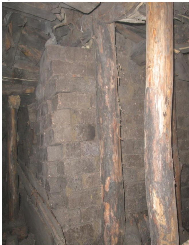
Рисунок 4.2 - Зазор между кровлей и охранным сооружением: а) – для шахты «Рассвет-1»; б) – для шахты «Щегловская–Глубокая»;
