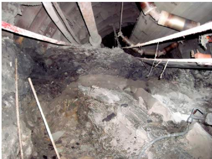
Рис. 2.23. Фотографии срезов пород почвы в местах поддирки почвы конвейерного штрека 8-й западной лавы пл. т 3 на расстоянии 35 м от лавы до: а) замерная станция №1; б) замерная станция №2
