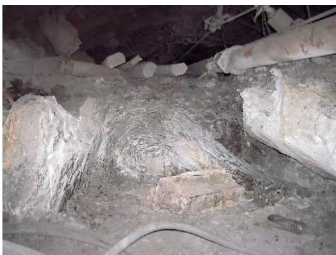
Рис. 2.24. Фотографии срезов пород почвы в местах поддирки почвы конвейерного штрека 8-й западной лавы пл. т 3 на расстоянии 35 м от лавы до замерной станции №3: а) общий срез почвы; б) место разлома слоя известняка
