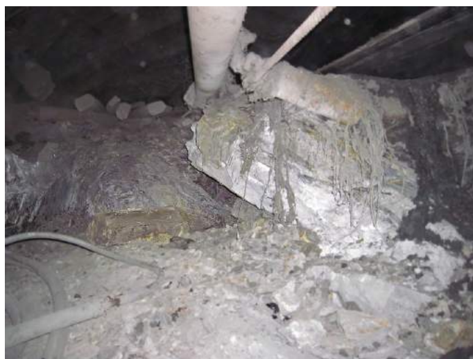
Рис. 2.24. Фотографии срезов пород почвы в местах поддирки почвы конвейерного штрека 8-й западной лавы пл. т 3 на расстоянии 35 м от лавы до замерной станции №3: а) общий срез почвы; б) место разлома слоя известняка
