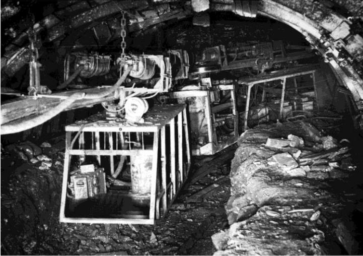
Рис. 15. Общий вид шахтной подвесной монорельсовой дороги с локомотивом на откаточном квершлагге  $l_8^1 - m_2$  горизонта 1550 м и ходке №1 пласта  $m_2$  шахты «Горняк»
