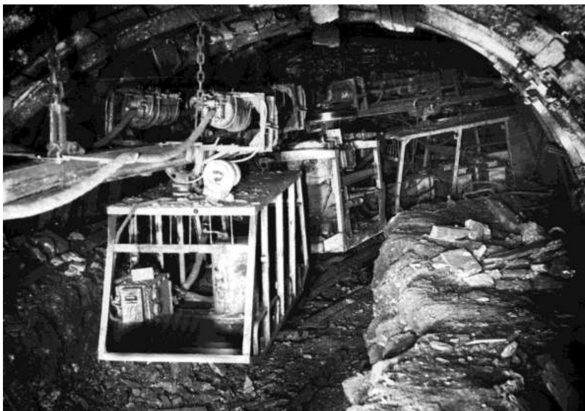
Рис. 8.1. Общий вид шахтной подвесной монорельсовой дороги с локомотивом
